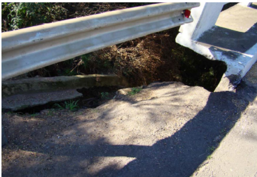
Foto 36 – Detalhe drenagem lado direito – Lado Santana da Boa Vista
