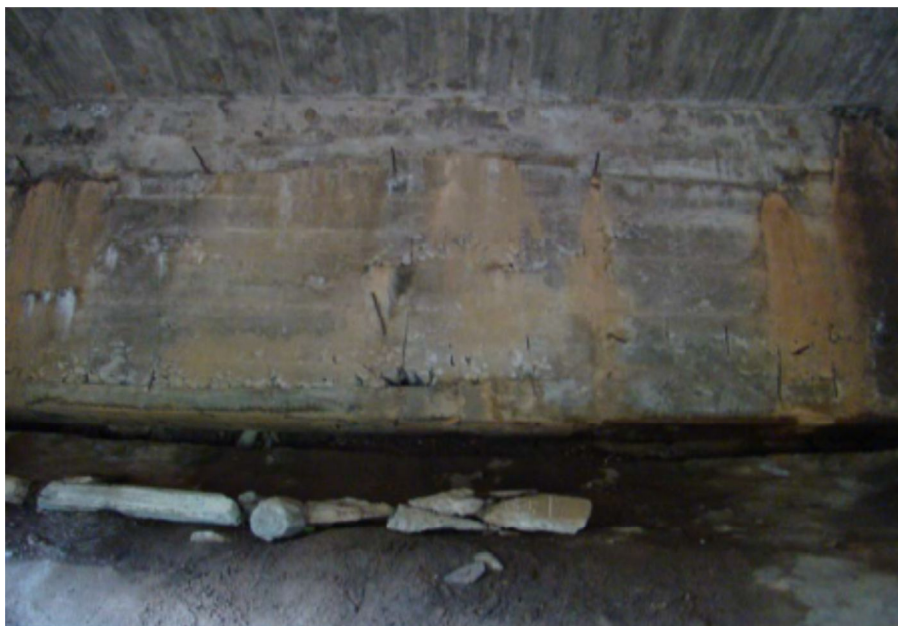
Foto 16 – Detalhe transversina de entrada – Lado Pelotas
