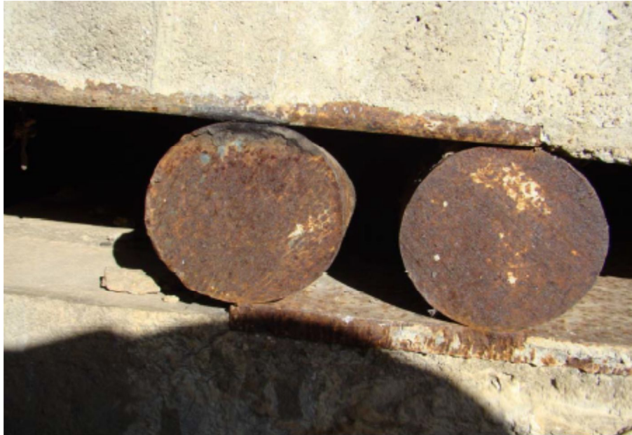
Foto 05 – Detalhe roletes duplos – Apoio P1
