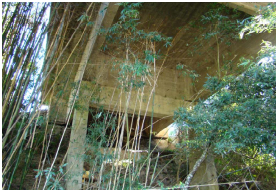
Foto 10 – Pilares Apoio P4
