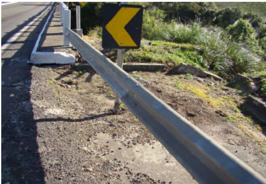
Foto 35 – Detalhe drenagem lado direito – Lado Pelotas
