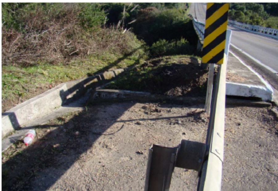
Foto 36 – Detalhe drenagem lado esquerdo – Lado Pelotas
