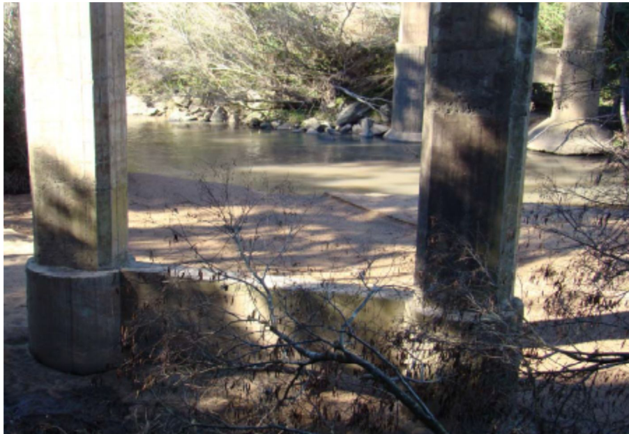
Foto 11 – Detalhe tubulões Apoio P2 e P3
