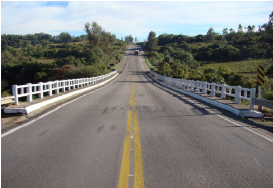
Foto 01 – Vista geral da obra
