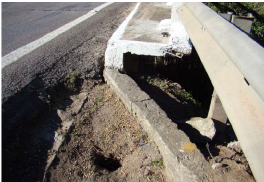
Foto 37 – Detalhe drenagem lado esquerdo – Lado Santana da Boa Vista
