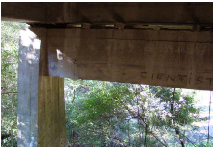
Foto 12 – Detalhe travessa Apoio P4
