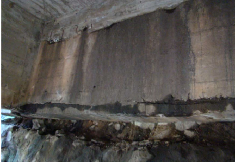
Foto 19 – Detalhe transversina de entrada – Lado Boa Vista
